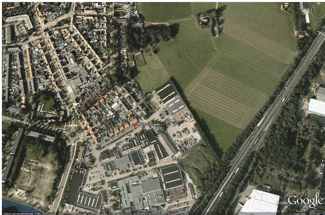
Fig. 2: Ligging bedrijventerrein Meidoornlaan, luchtfoto
